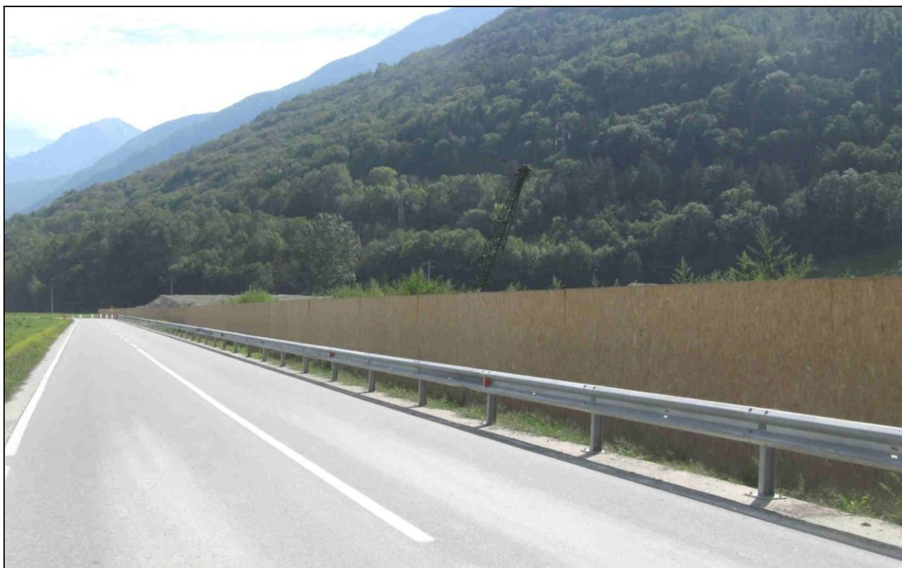
Figura 12.1 – Esempio di barriera fonoassorbente e per contenimento polveri
